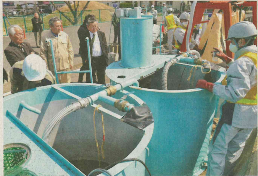
側溝にたまった汚染土壌を洗浄した新システムの実証実験
