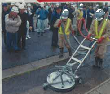
路面を高圧洗浄する新システムのの実証実験
